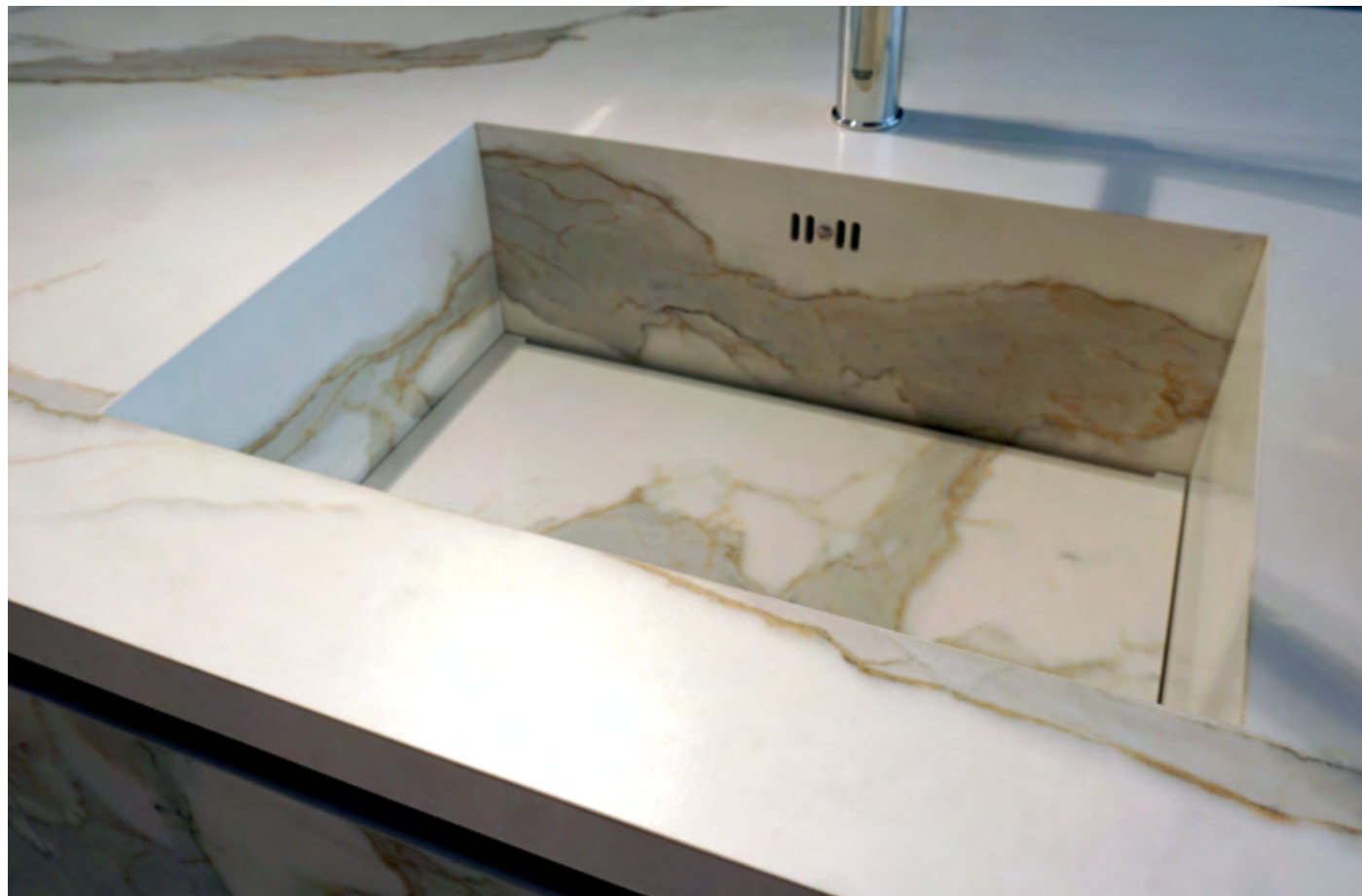
Integrirani sudoper, kompletno izrađen od porculanske ploče sa vrhunskom preciznošću spojeva i kuteva sudopera Integrated sink, completely made of porcelain tile with superior precision of joints and corners of the sink
